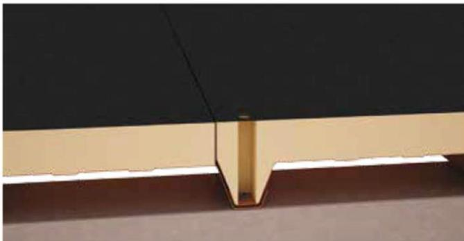
Die entsprechende Befestigungsschraube an der tragenden Unterkonstruktion anziehen (z. B. unter Zuhilfenahme von Bohrschrauben). Dann das Kernloch mit **Polyurethanschäum** oder einem anderen Dämmstoff ausfüllen.
